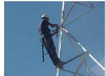
Posicionamiento en apoyo de celosía
